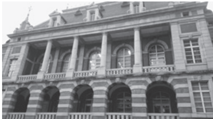
立派な法務省旧本館
